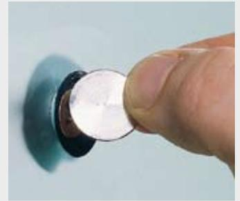
**4)** Flächenbündige Abdeckscheibe einclipen – fertig!
